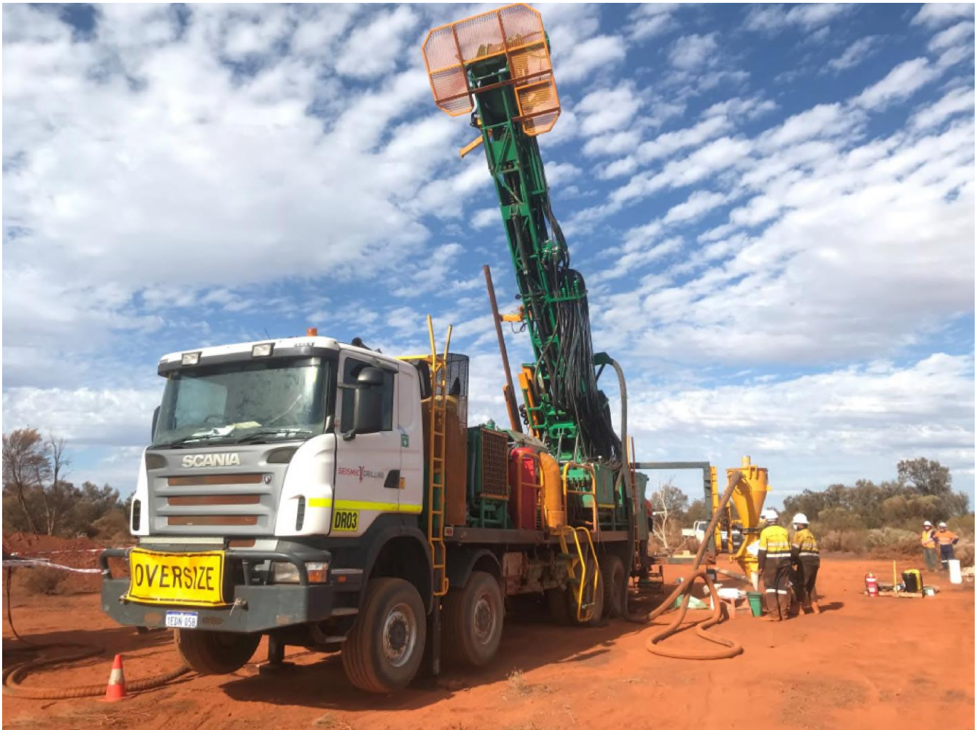
Abbildung 2. Seismic Drilling Services bohrt Bohrziel 4 auf Gray Dam
